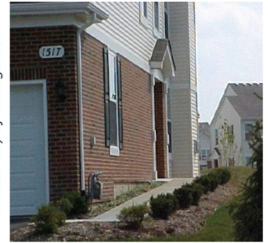
Una puerta sin escalones construida sobre el sótano
